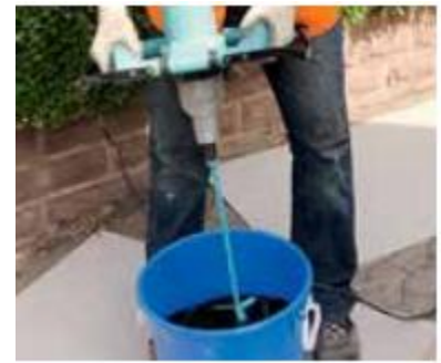
3. ערבבו היטב את השרף R עם המילוי S, ערבבו עם המקשה למשך כ 2 דקות
